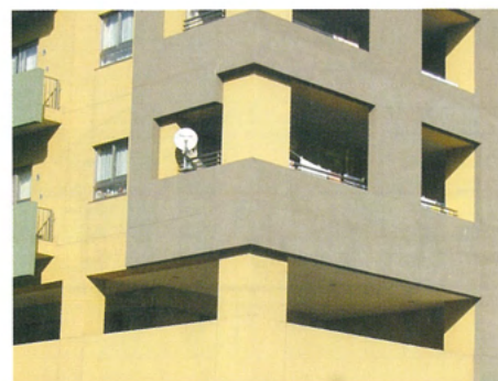
外壁等の仕上 (セントラルパーク・ウェスト)
