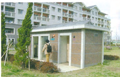
公衆便所（アクアダクトパーク）
