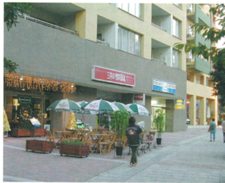
沿道商業施設（セントラルパークウェスト）
