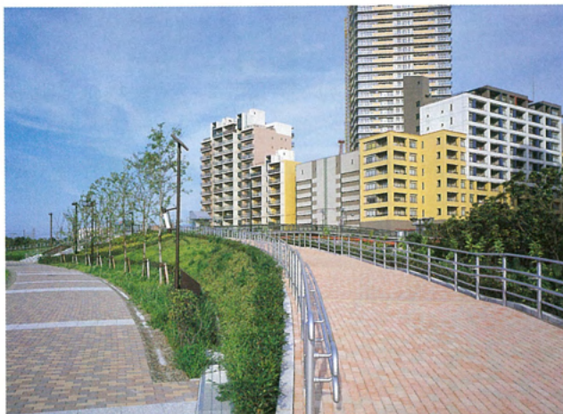
マリンデッキ（幕張海浜公園側入口、スロープ）
