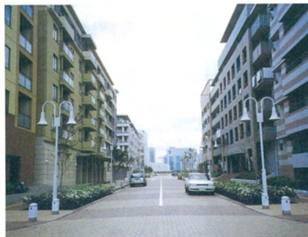
コミュニティ路の舗装(15号線)
